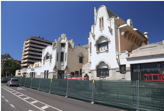
La Farinera amb les tanques de protecció per les obres en curs MANEL LLADÓ.
