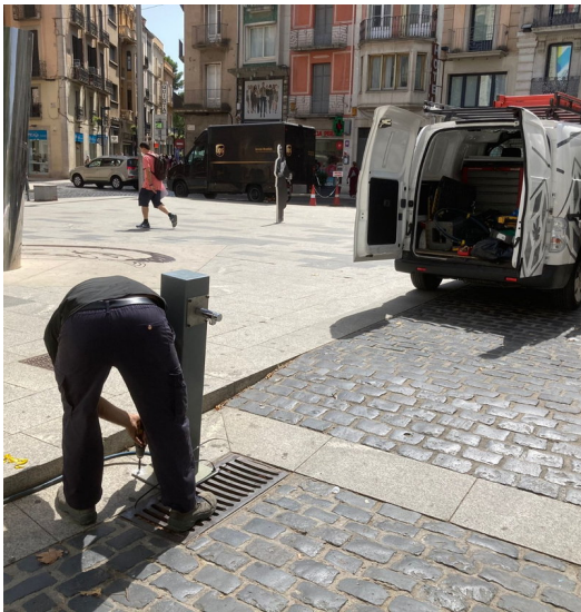
Un operari instal·lant una font ahir al matí a ple sol, a Figueres AJ. DE FIGUERES.
