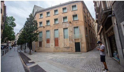
L'edifici de l'antiga central del Molí, al carrer Santa Clara de Girona, en una imatge presa ahir. QUIM PUIG.
