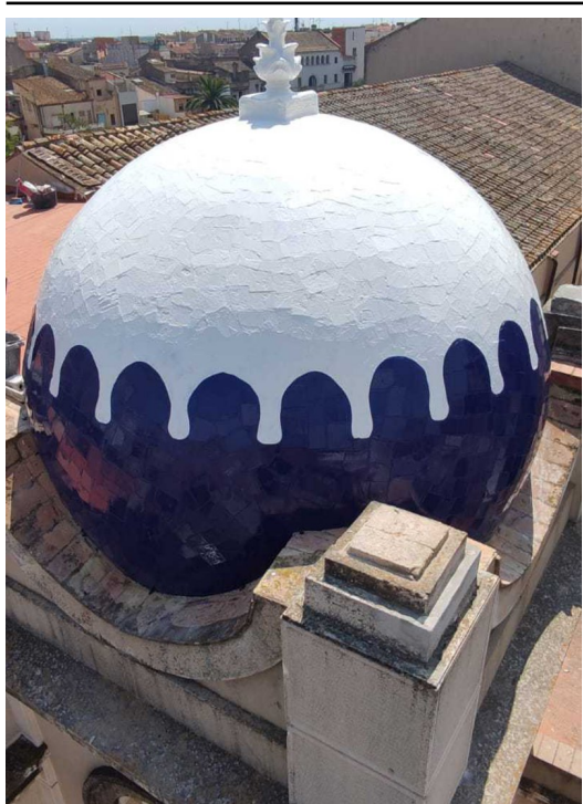
Una de les boles impermeabilitzades que formen part dels treballs de millora de la coberta AJ. FIGUERES.
