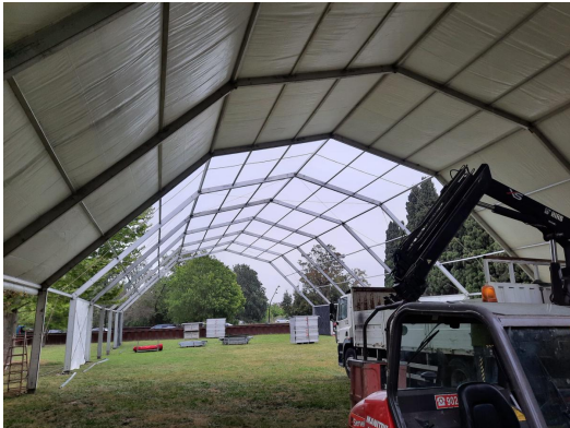
La carpa que s'està instal·lant al Parc de les Aigües
