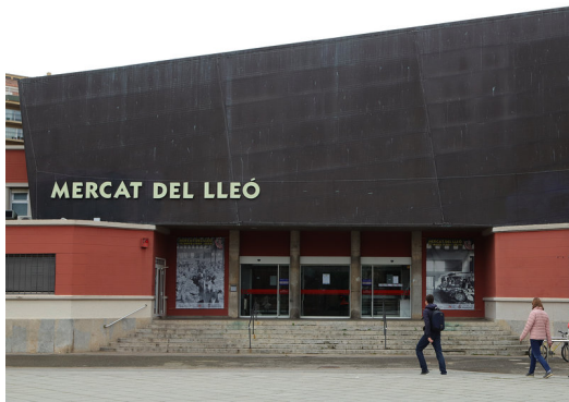
El mercat del Lleó, un dels espais on s'instal·laran plaques solars MANEL LLADÓ.
