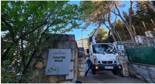
Comença la tala dels arbres perillosos a l'entorn de l'escola de Montjuïc
