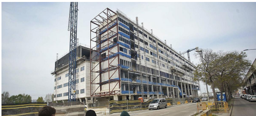
L'estructura de la clínica en la seva façana principal, a la carretera Barcelona.
