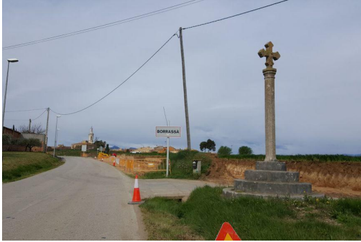
El carrer Mar amb la creu del terme, durant les obres.
