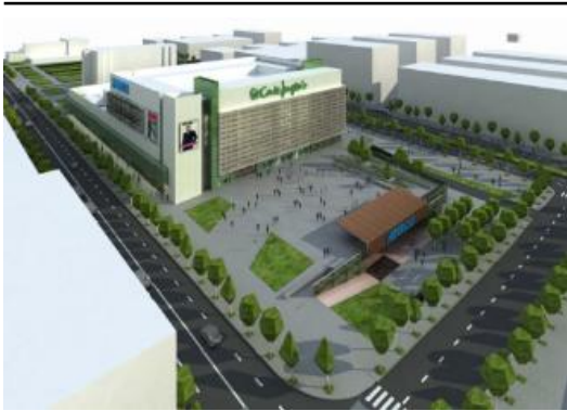
Imatge virtual del final de les obres.
