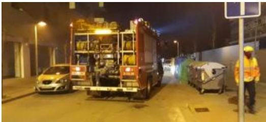
Els Bombers davant l'edifici afectat
