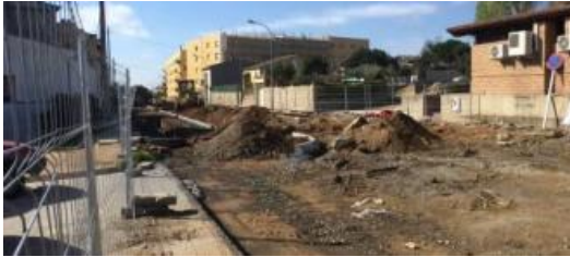
El carrer Carrilet, aixecat per les obres.
