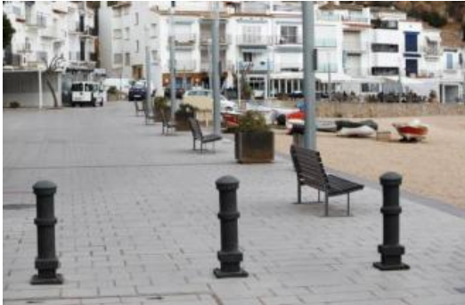
El passeig del Mar, on s'ha de fer la intervenció de sanejament.
