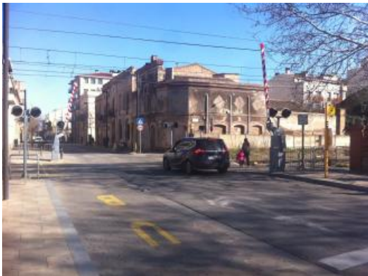
El pas a nivell, reobert al trànsit.
