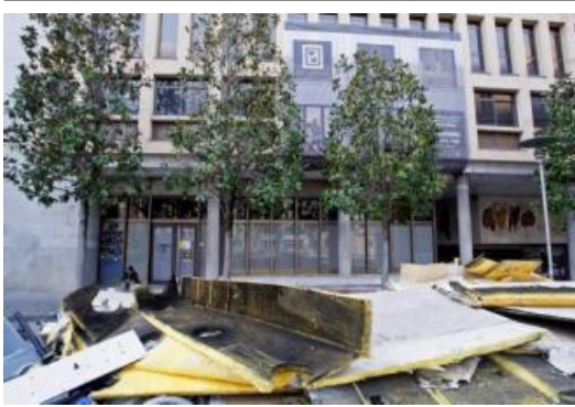
Façana de l'edifici del carrer Santa clara, on ja han començat les obres.
