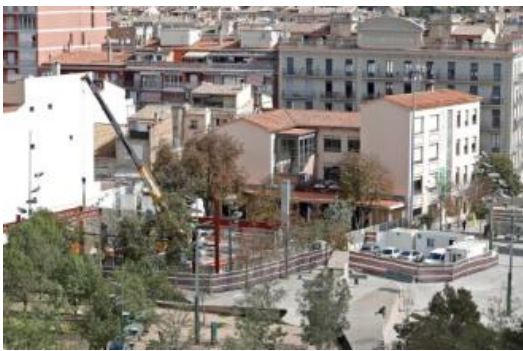
Les obres del pati de l'escola Eximenis, en una imatge d'arxiu.
