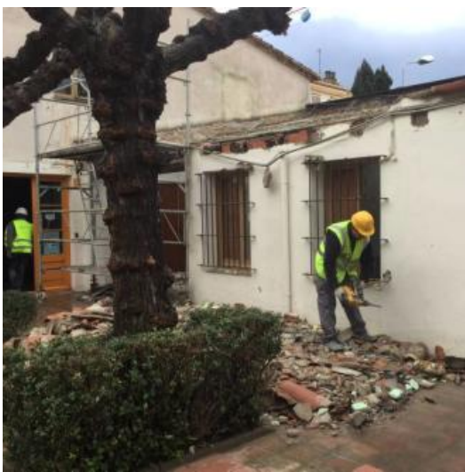
Imatge dels treballs a l'edifici Can Genís.
