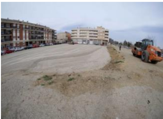
La maquinària i operaris ja han iniciat l'obra.
