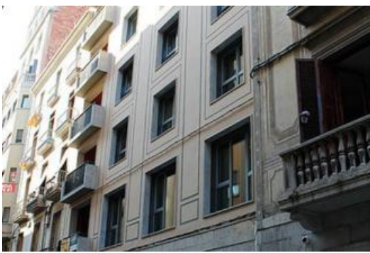
Façana principal de l'edifici del carrer Nou.
