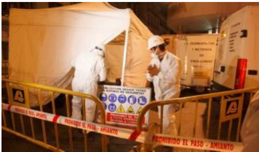
Actuació, amb protecció, en una claveguera de la carretera Barcelona, l'any 2009.
