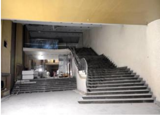
L'interior del cinema, que està en obres.
