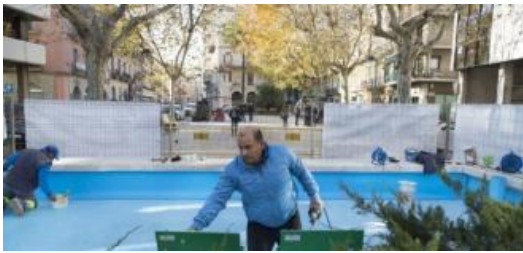
Operaris treballant a la restauració de la font
