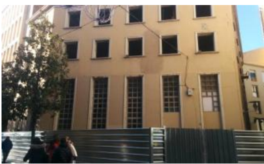
Les tanques al carrer Santa Clara ja evidencien l'immiment inici de les obres a l'edifici del Molí.
