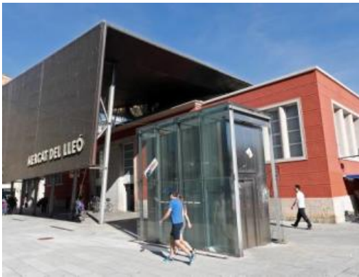
Els ascensors per accedir a l'aparcament soterrats estan a prop d'una entrada del Mercat.
