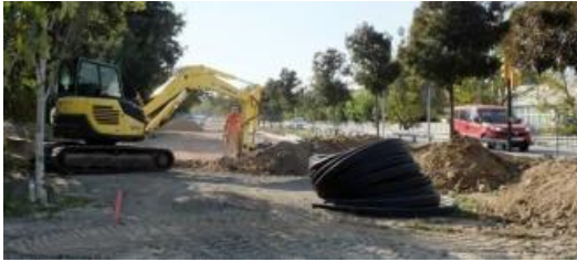
Operaris treballant a l'aparcament paral·lel a l'N-260.
