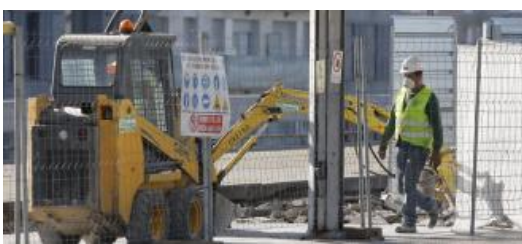
Obres, de dia, a les andanes.
