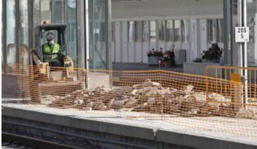
Obres a les andanes de l'estació de Renfe i al parc Central
