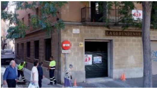
Obres a l'edifici de l'antiga clínica de l'Esperança, a la plaça Catalunya.
