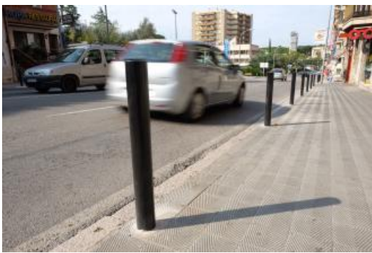
Figueres condiona la vorera de l'avinguda Salvador Dalí
