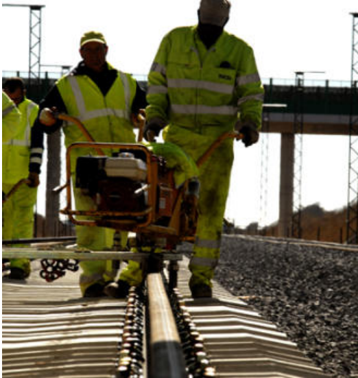
Les obres han començat aquest dilluns, 25 de setembre.
