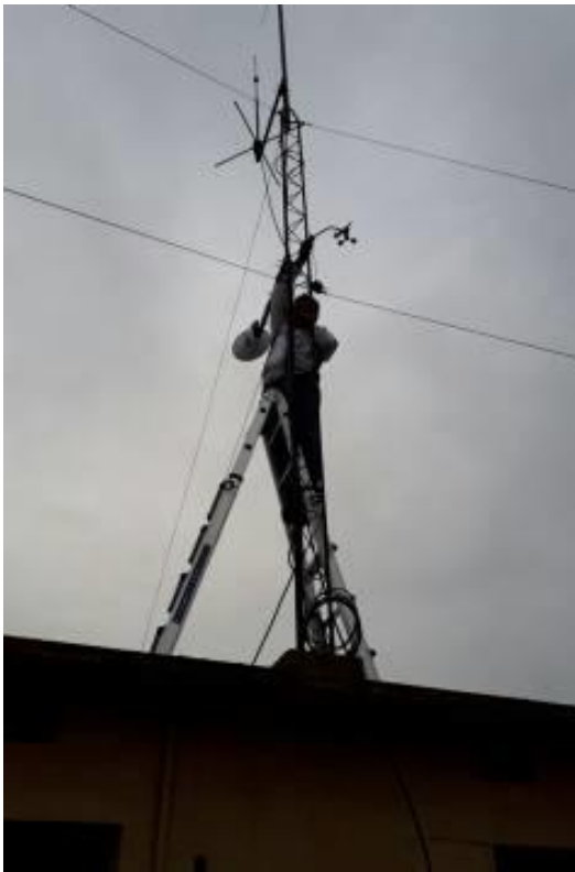
Instal·lació de l'aparell.
