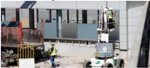
Operaris retirant els vidres del túnel que unia la Renfe i el TAV.
