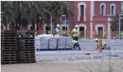
Obres al parc Central després d'una aturada de quinze dies
