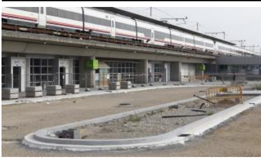
Obres al parc Central de Girona
