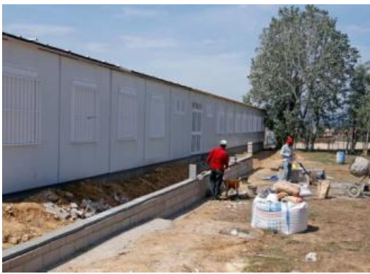
Les obres al sector de Can Prunell, per consolidar el barracó.
