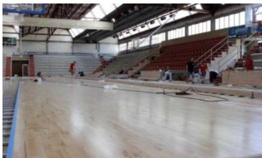
Treballs a la pista del pavelló de Palau.
