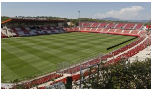
Últims detalls de les obres a Montilivi
