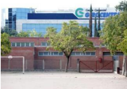
Les obres del pati del Cassià Costal s'iniciaran el 16 d'agost.
