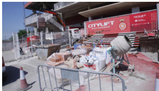
Obres a Montilivi
