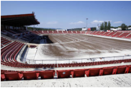
Obres a Montilivi
