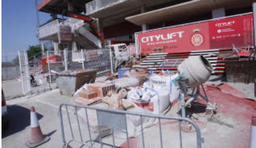
Obres a Montilivi
