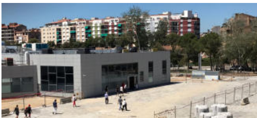
Obren la nova porta d'accés a les estacions del TAV i d'autobusos
