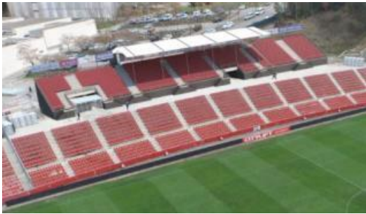
Aspecte de les noves graderies de l'estadi de Montilivi
