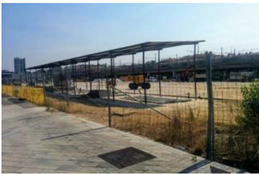
La carcassa dels edicles de la zona sud de la llosa del parc Centra, ja sense els murs de formigó.
