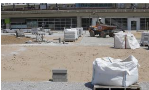
Pavimentació dels vials de la zona nord del parc Central
