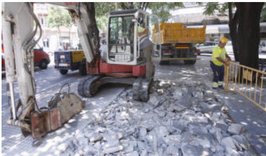
Obres a la cruïlla de Jaume I amb Eiximenis
