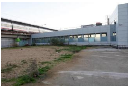
L'actual «finger» o passadís cobert s'enderrocarà per deixar pas a una marquesina.
