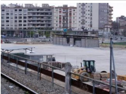
Les obres del parc Central, en una imatge recent.
