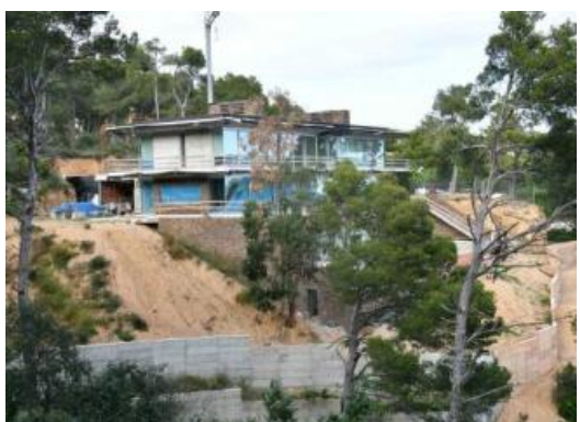
Imatge d'arxiu de les obres a la finca del Golfet.
