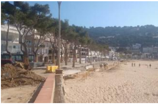
El passeig de Llafranc està en obres des del novembre.
